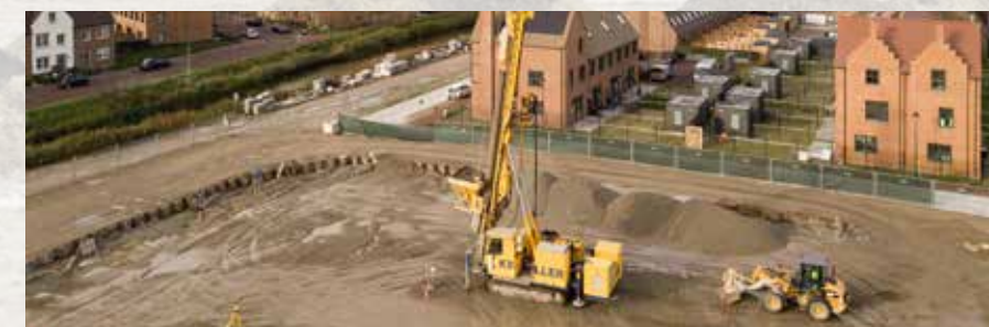
In Nederland is recent het eerste meerlaagse bouwproject gefundeerd op in totaal 350 grindkolommen van 12 meter diep.
